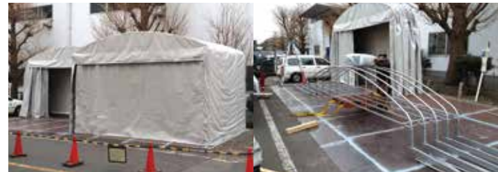
●仮置きブース アーチタイプ・カーテン/固定張テント・軽量帆布 グレー（廃盤）・敷鉄板 ・W:5.3m×L:5m×H:3m
